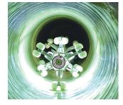
生材に強固なガラス繊維を採用することで、高強度な 新しい管を既設管内に構築することができます。
