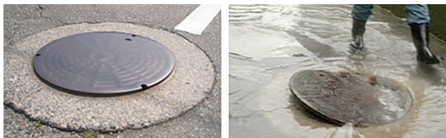
写真1 表面が摩耗したGM
