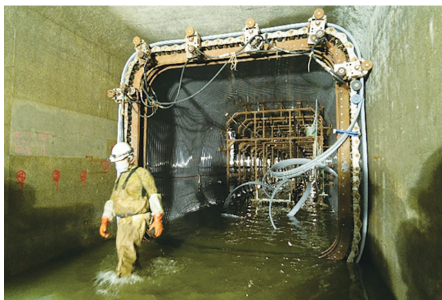
SPR工法 施工現場
