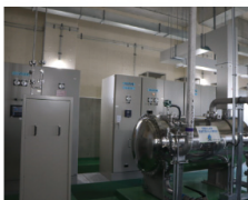
高度海水処理オゾン発生器
