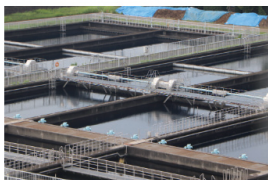
フロック形成池・薬品沈降池
